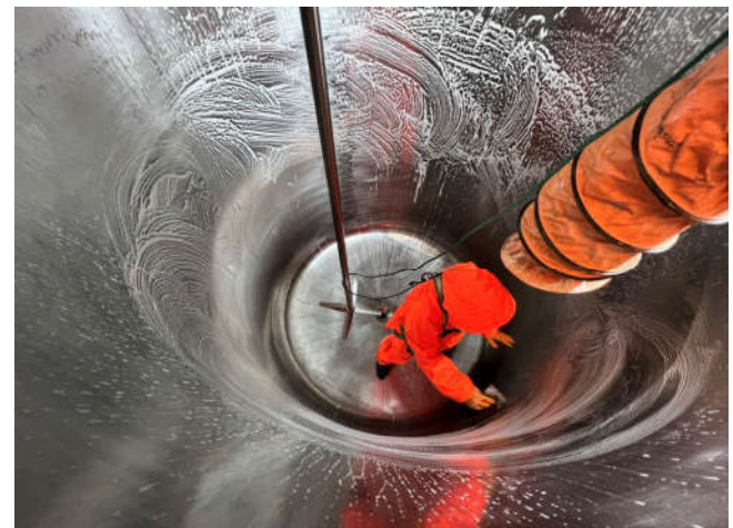
Clean 汚れ落とし
