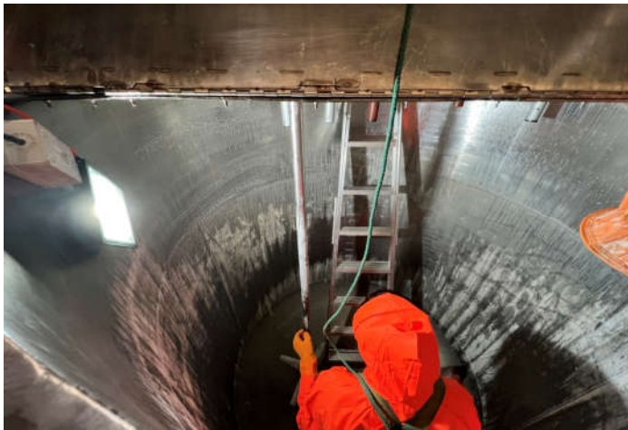
Clean 汚れ落とし
